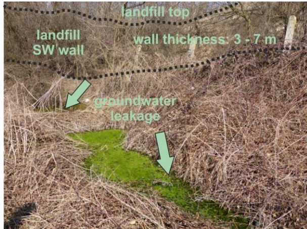
Fig. 5 Landfill contaminated seepage at a SW wall foothill Obr. 5 Kontaminované zamokrenie pod JZ stenou skládky
