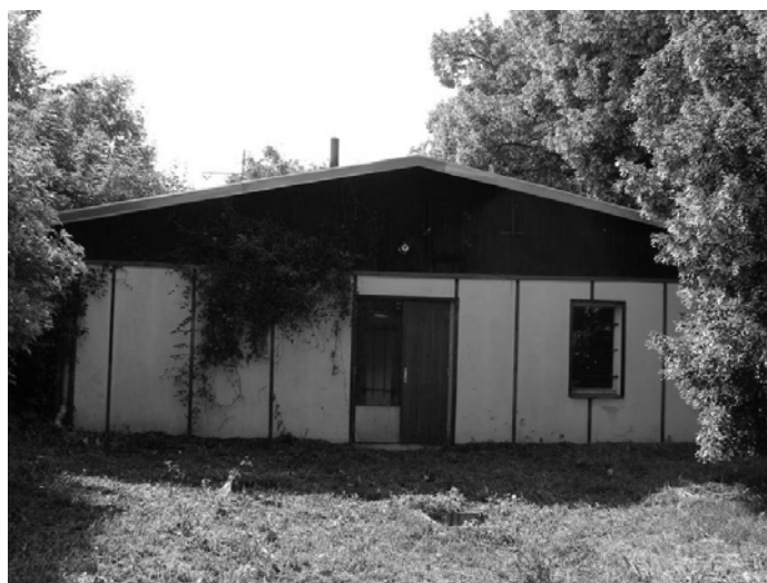
Obr. 4 Lehká dřevostavba provozně-sociálního objektu s obklady s obsahem azbestu (z roku 1978), Brno, 2012 Fig. 4 Light wood-construction of operational and social object involving boards with asbestos content (built 1978), Brno, 2012
