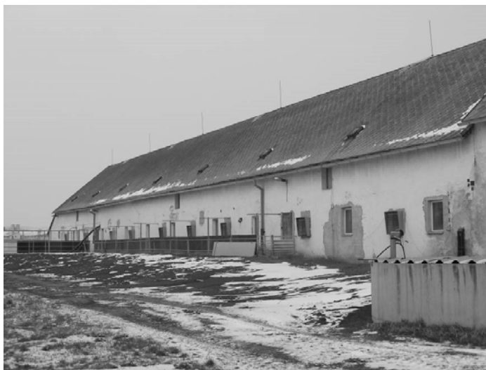
Obr. 1 Krytina z azbestocementových šablon na stáji pro výkrm vepřů (z roku 1965), Suchohrdly u Miroslavi, 2012
