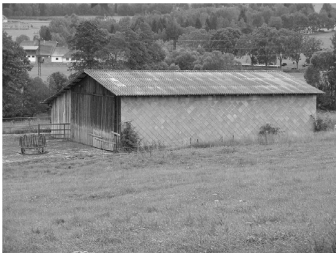
Obr. 2 Krytina z azbestocementových vlnitých desek a vnější plášť z azbestocementových šablon na stáji (z roku 1982), Stachy, 2005
