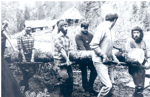
Obr. 38: Generálna rekonštrukcia dolnej, kvačianskej hate (zdroj: Mikuláš Huba)
